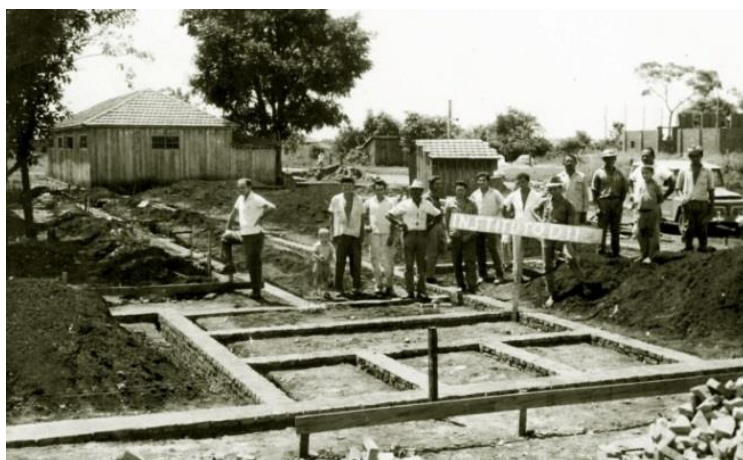
Figura 2 – Fase inicial da construção do “Instituto ‘D. Pedro II’” (1966)
