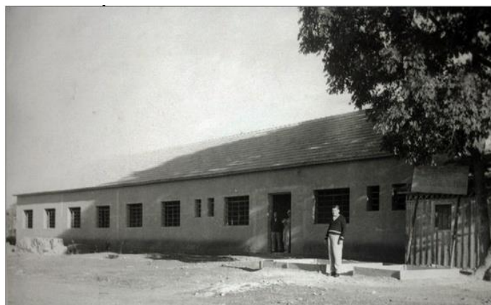
Figura 3 – Construção adiantada do “Instituto ‘D. Pedro II’” (1966)
