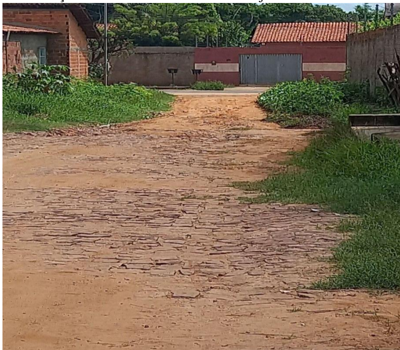
Figura 08 - Calçamento em via secundária do conjunto habitacional Novo Jóia.
