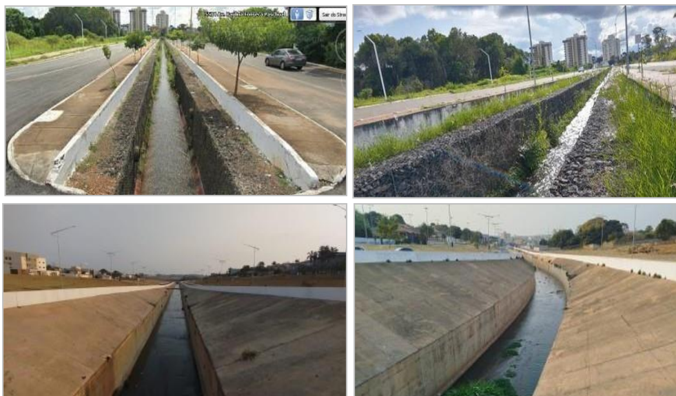
Mosaico 1: Trecho Superior e Trecho Inferior da Canalização do Córrego Pirapitinga
