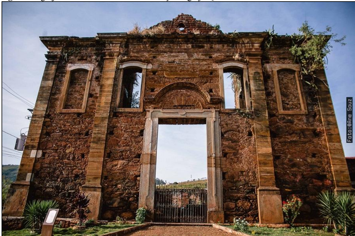
Figura 3: Igreja de Nossa Senhora da Conceição “Igreja Queimada”
