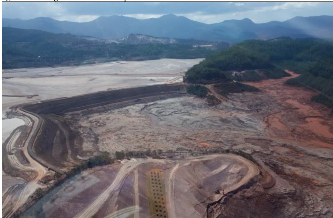
Figura 5: Barragem do Fundão rompida em 5 de novembro de 2015
