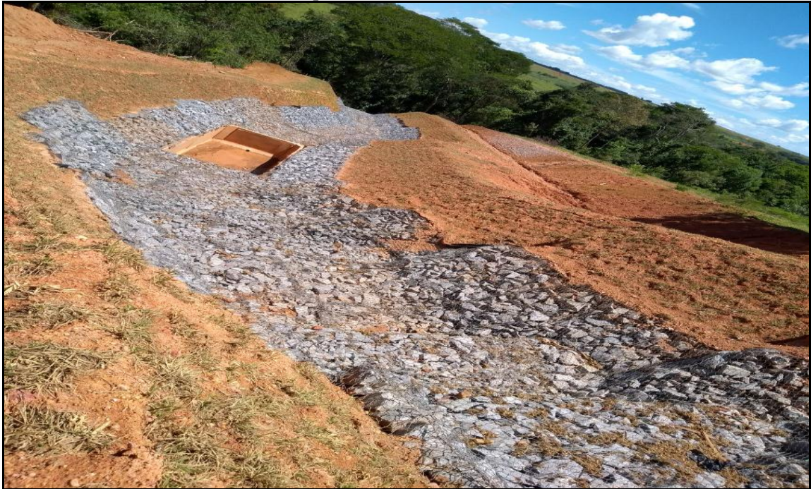
Figura 12: Vista da Voçoroca 2 recuperada
