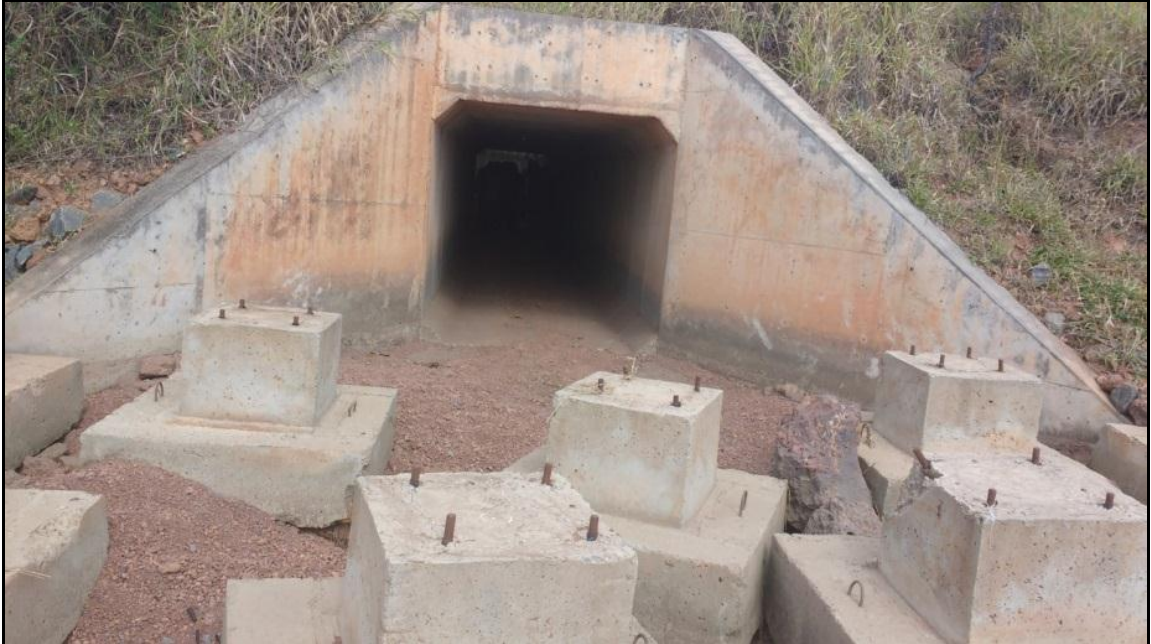
Figura 06: Vista da galeria com denteção de concreto
