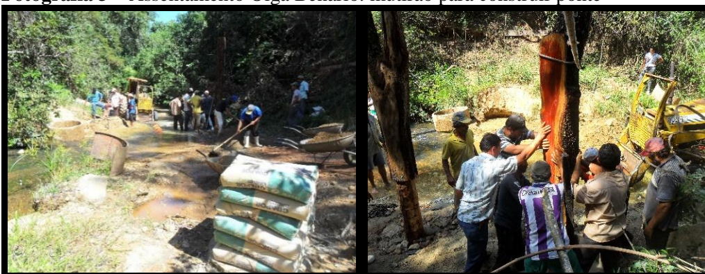
Fotografia 3 – Assentamento Olga Benário: mutirão para construir ponte
