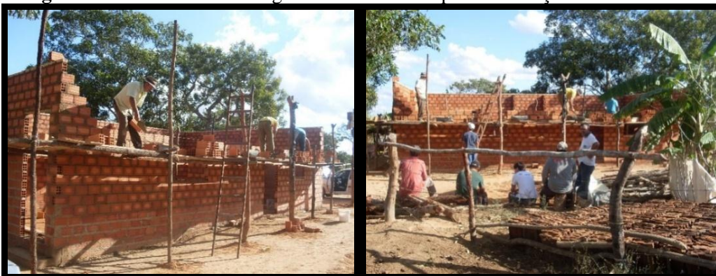
Fotografia 2 – Assentamento Olga Benário: mutirão para construção de moradia
