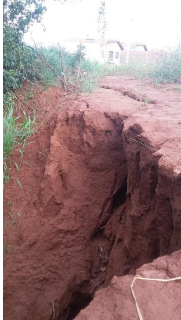
Foto 6 – Ponte sobre a voçoroca
