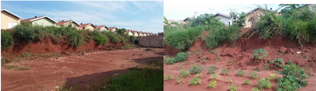
Fotos 1 e 2 – Cortes no talude
