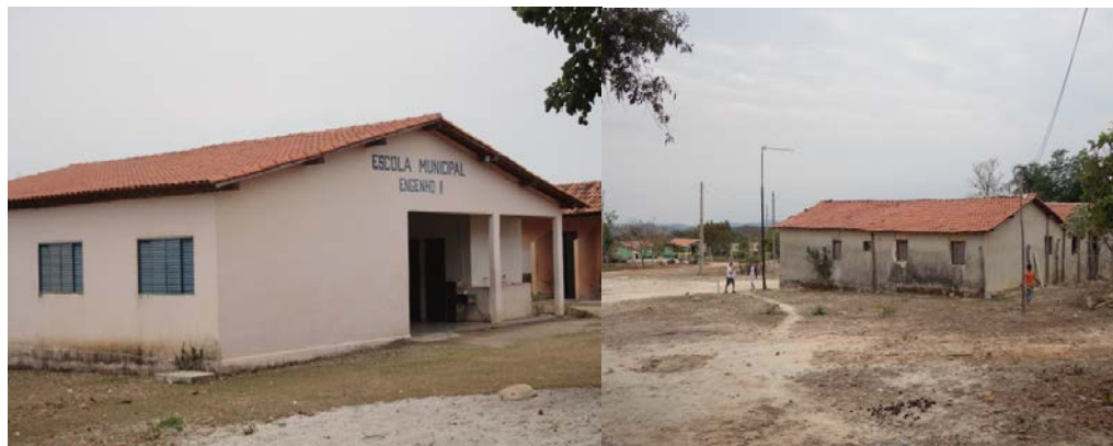
Foto 11 - Escola Kalunga e estrutura das moradias (2013).
