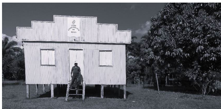
Figura 4 Templo da Igreja Assembleia de Deus na Comunidade Independência, Rio Purus, município de Boca do Acre (AM). Acervo pessoal - Abril de 2023.
