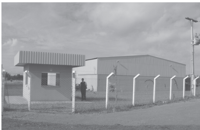
Foto 1: Vista frontal da sede da Fórmula R Indústria, localizada no DIMIC, próximo ao Site da Mitsubishi em Catalão. (03 mar. 2010). Autora: SILVA, M. V. da. Mar. 2010.
